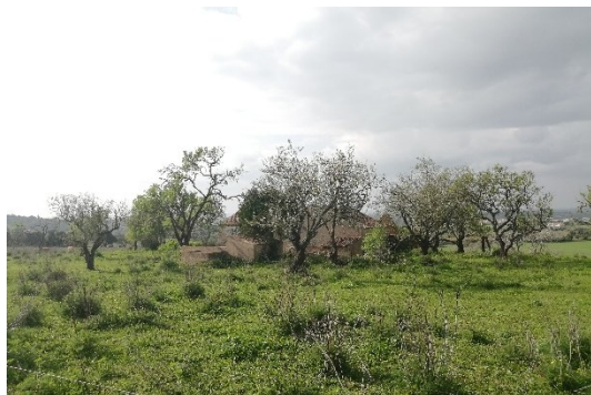
Figura 104. Vista de sul sobre o conjunto edificado 6
