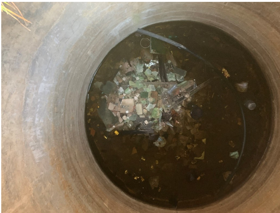
Figura 24. Aspeto do interior do poço P2
