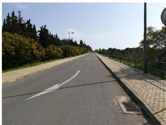
Figura 78. V9 troço nascente
