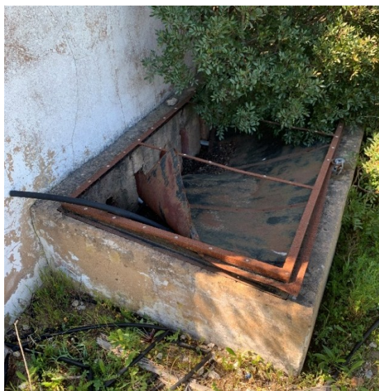
Figura 26. Pormenor da caseta de proteção do furo F1
