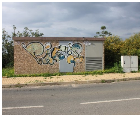
Figura 118. Posto de transformação
