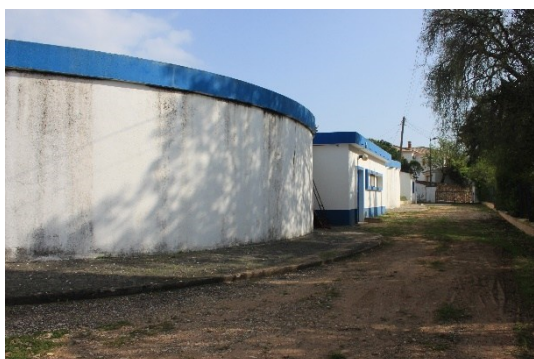
Figura 96. Vista de sul sobre o conjunto edificado 2
