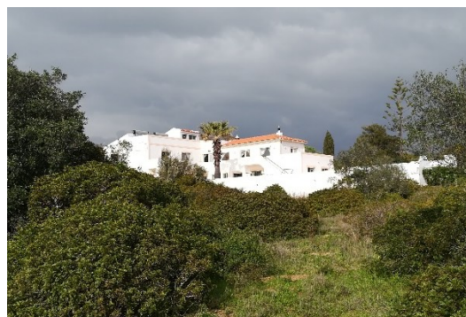
Figura 101. Vista de poente sobre conjunto edificado 4
