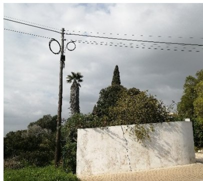
Figura 123. Cabos de telecomunicações
