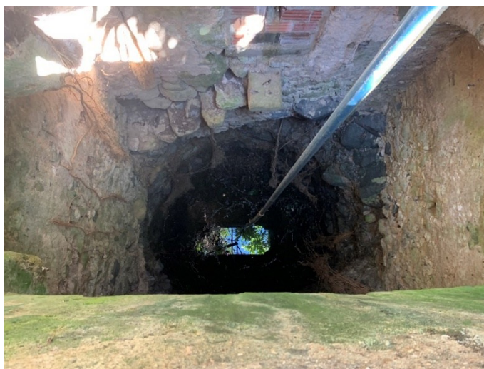
Figura 21. Enquadramento geral do poço P1
