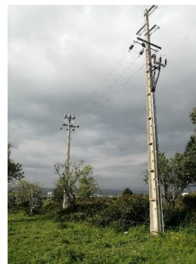
Figura 120. Linha de média tensão aérea
