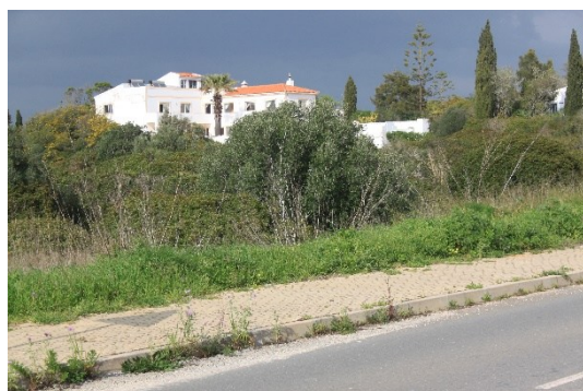
Figura 100. Vista de sul sobre o conjunto edificado 4
