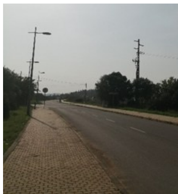
Figura 119. Iluminação pública e linha de média tensão aérea
