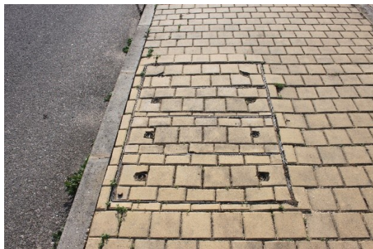
Figura 122. Caixas de telecomunicações
