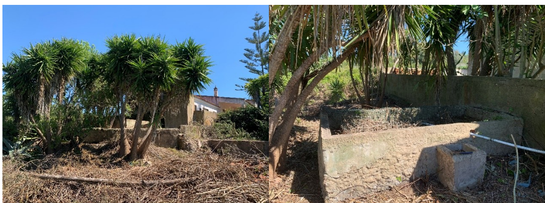
Figura 19. Enquadramento geral do poço P1
