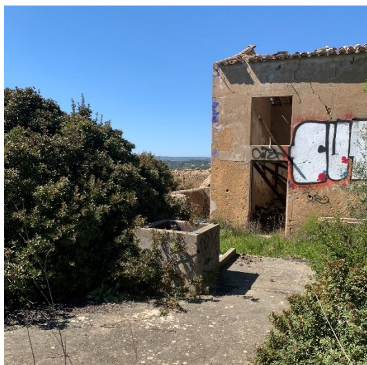
Figura 22. Enquadramento geral do poço P2
