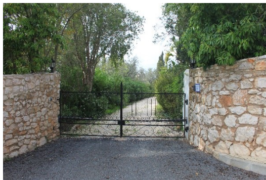
Figura 99. Vista de sul sobre o acesso ao conjunto edificado 3
