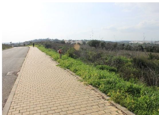
Figura 79. troço ponte da V9 sentido V1
