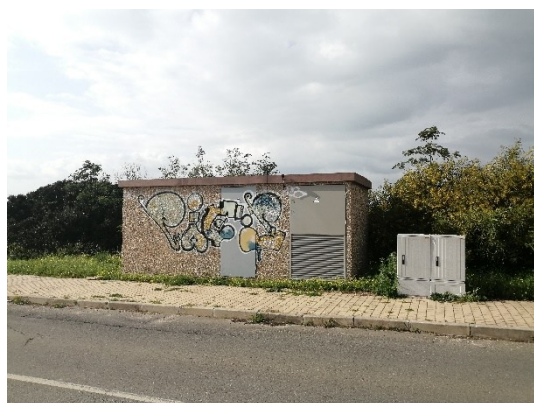
Figura 102. Vista de sul sobre o edifício 5
