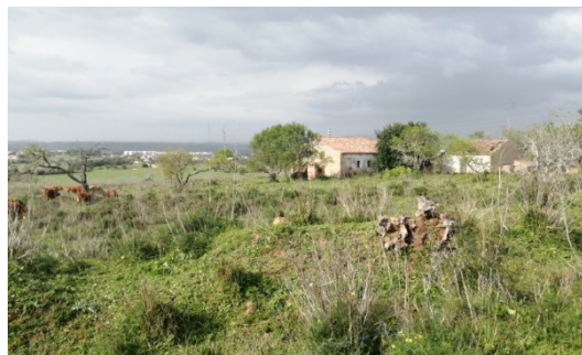
Figura 125. Edificado em ruínas
